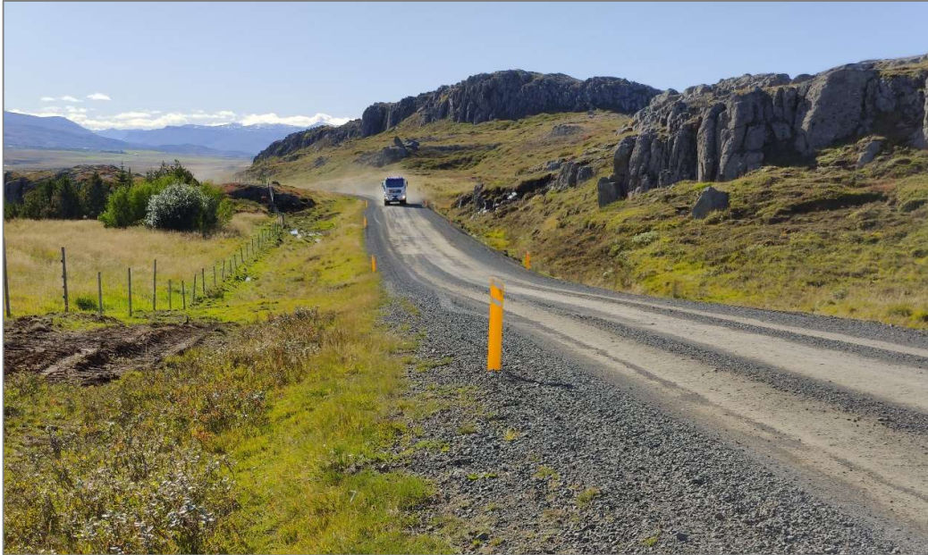
Mynd 10. Við Ketilsstaði, í grennd við stöð 10400, til suðurs (mynd: Mannvit, 2020).
